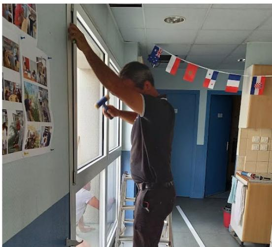
Le remplacement d'une baie vitrée fixe pour des fenêtres oscillo-battantes permet une bonne ventilation de la pièce principale. La pose de volets pare soleil a largement amélioré le confort d'été.
